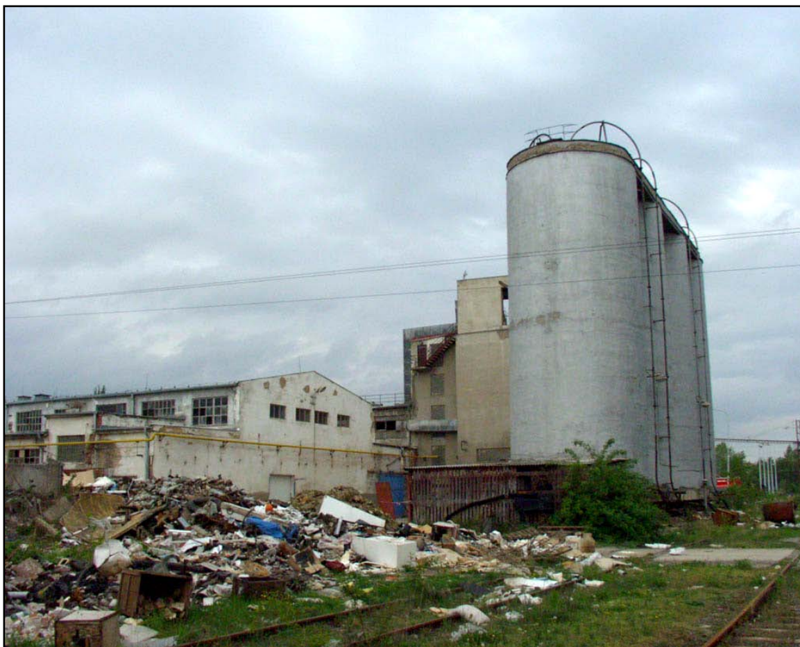
Obr. 1: pohled na část typické deprimující zóny s objekty určenými k demolicí
