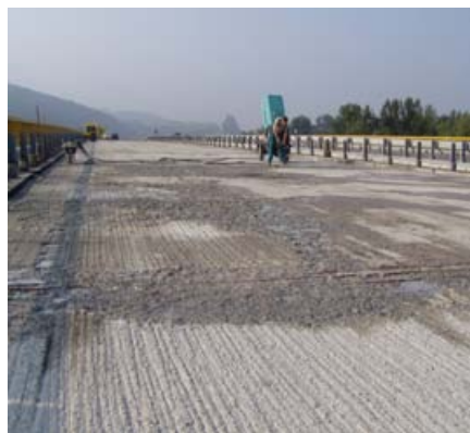
Obr.1: Príprava podkladu
