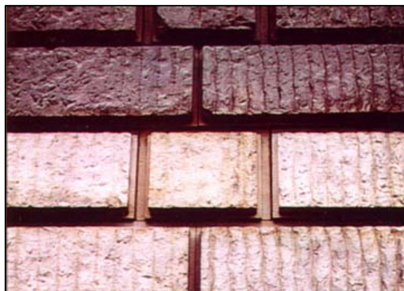
Obr. 4: Zkouška čistění granulátem – jako nosné médium je použita voda
