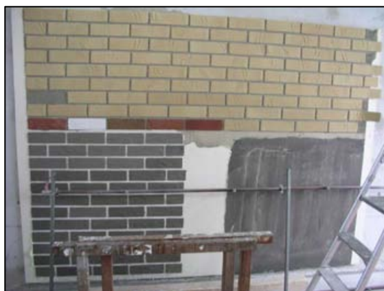
Obr. 4: Zkušební povrchy obkladů
