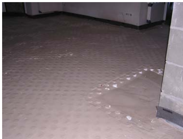
Obr. 4: Dvouvrstvé položení litého potěru – první vrstva
