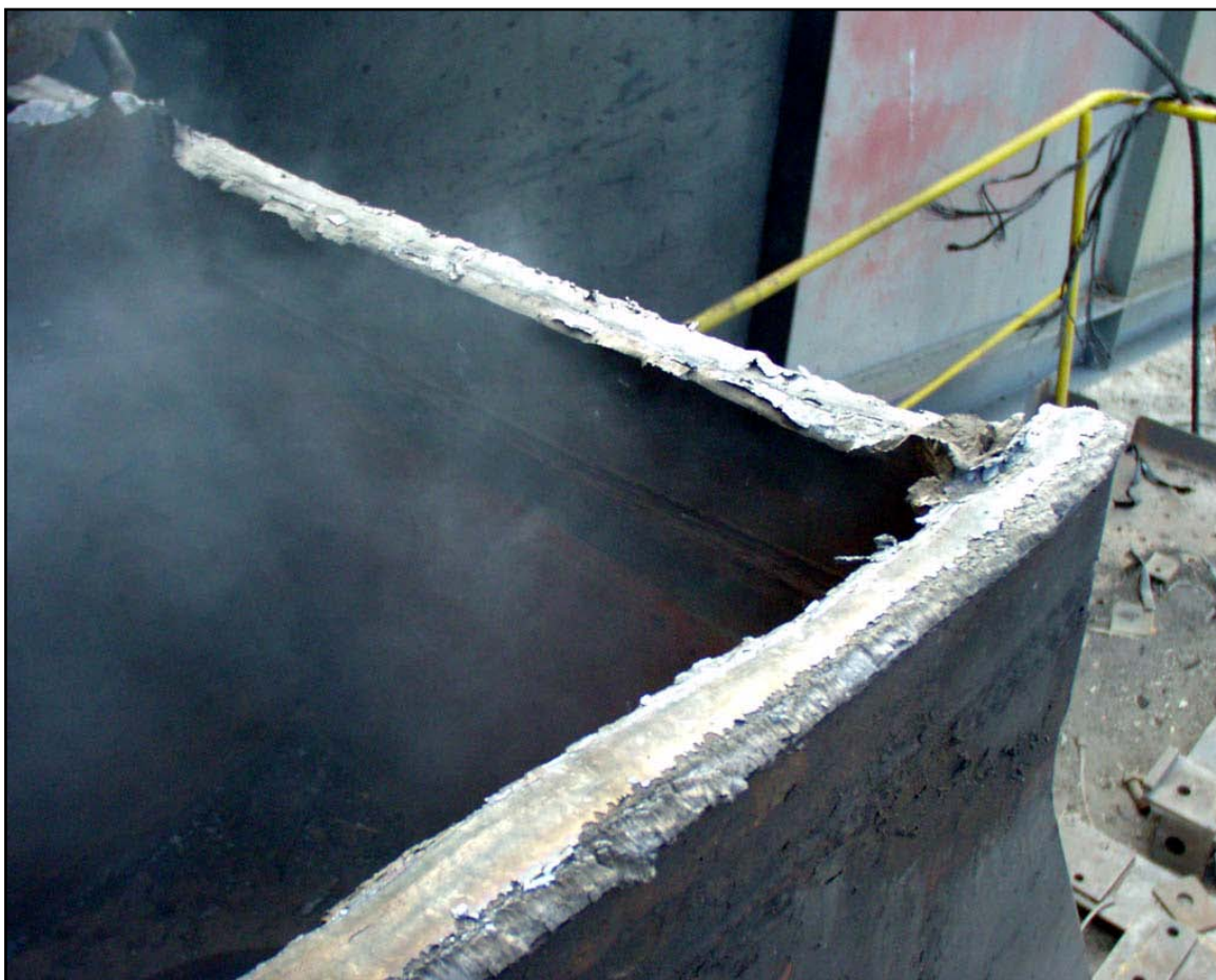
Obr. 3: řez na ocelovém skříňovém nosníku rozpojeném usměrněnou náloží
