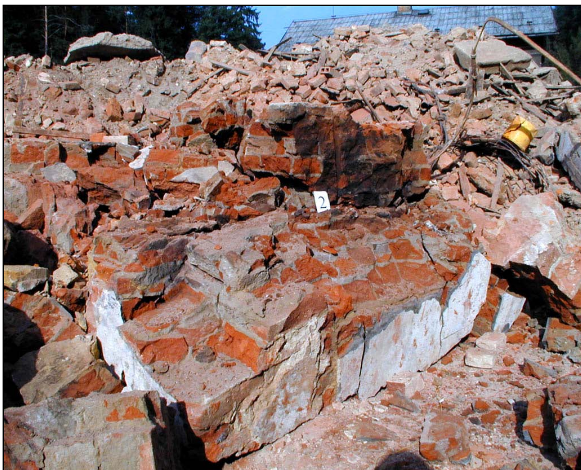
Obr. 2: blok cihelného zdiva rozpojený náloží pastovité trhavin
