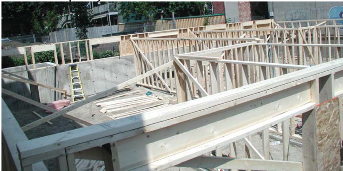
Na obrázku jsou zachyceny prvky lehkého dřevěného skeletu při výstavbě polozapuštěného přízemí. Před montáží konstrukčního pláště je velmi důležitá kontrola pravoúhlosti nosných rámu.
