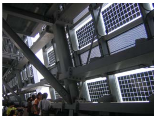
obr. 5 – systém “sloupek – příčle” [3]
