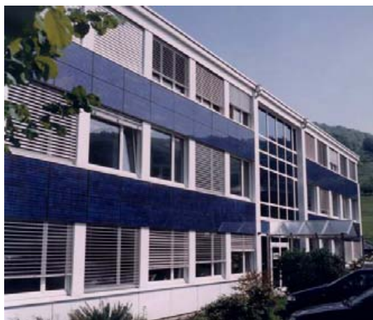
obr. 11 – instalace systému Aluhit [5]
