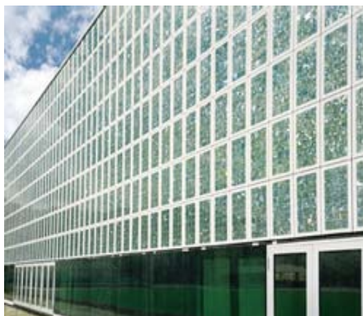
obr. 12 – instalace systému Aluhit [5]
