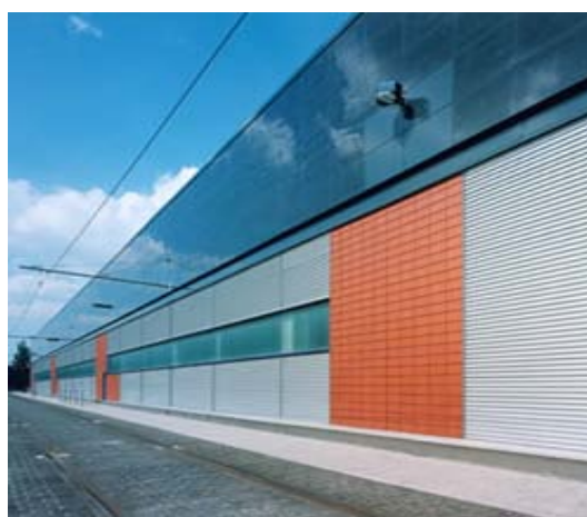
obr. 10 – instalace systému Aluhit [5]
