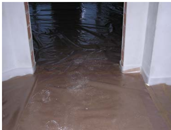
Obr. 3: Položení voskovaného papíru (krycí fólie) a dilatačních pásků
