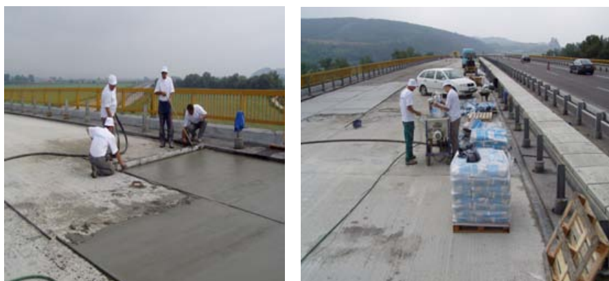
Obr.2 Aplikácia sanačnej vrstvy EMACO® T 450
