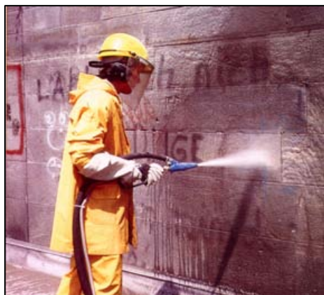
Obr. 4: Zkouška čistění granulátem – jako nosné médium je použita voda
