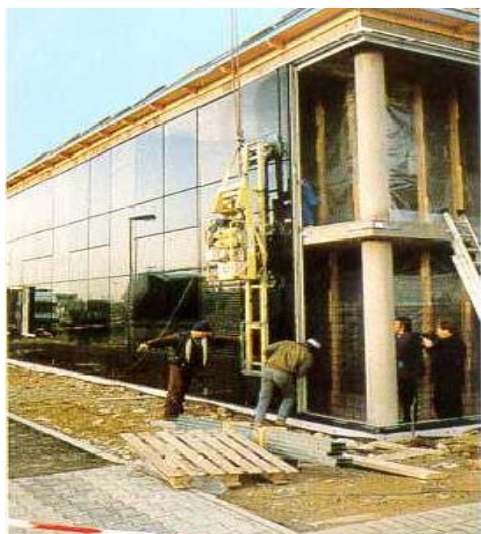
obr. 15 – instalace prefabrikovaných panelů pomocí přísavek [7]
