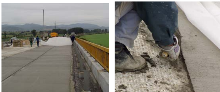
Obr.3 Zabezpečenie technických podmienok sanácie EMACO®
