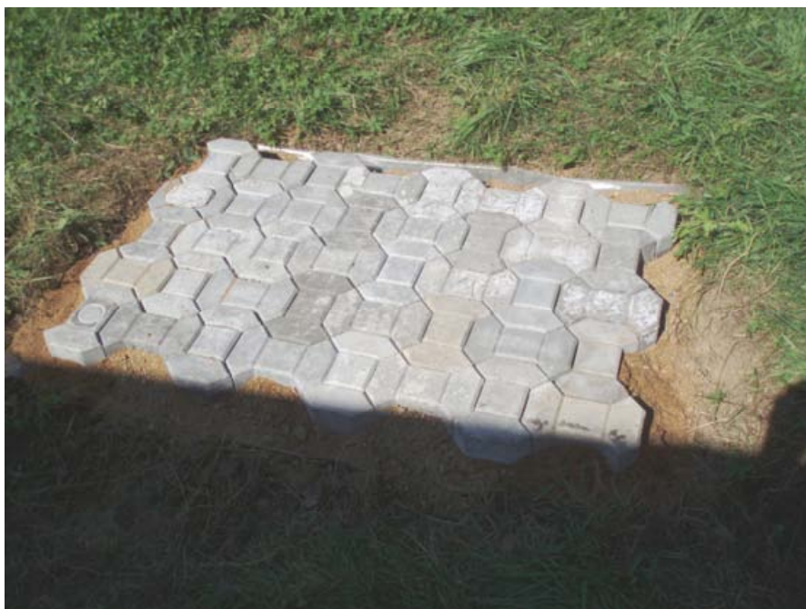
Experimentální úsek zámkové dlažby ve venkovním prostředí
