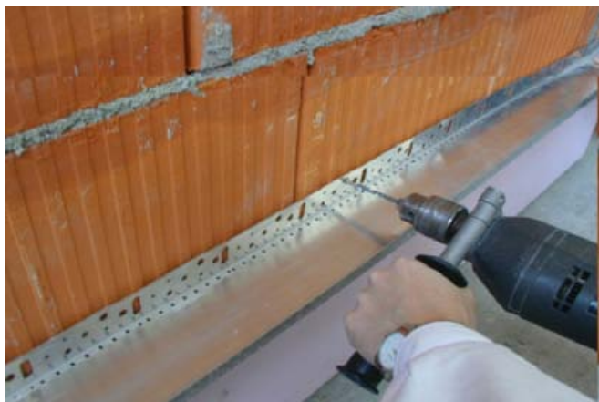
Obr. 3 Osadenie ukončovacej lišty s využitím doplnkových elementov
