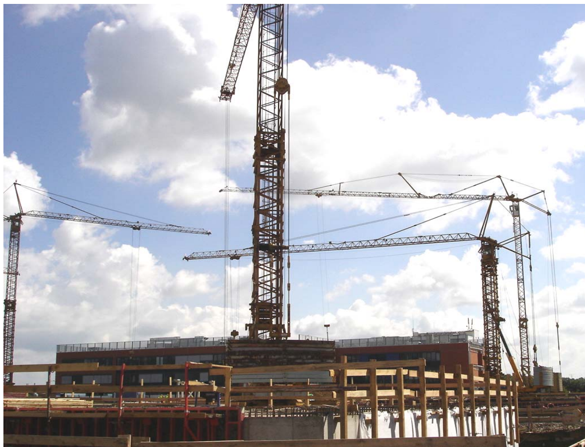
Obr.1: Jeřáby patří mezi nejčastěji používané a také nejdražší stroje v pozemním stavitelství
