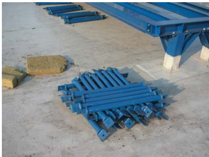
Provádění VZT po dokončení střešního pláště
