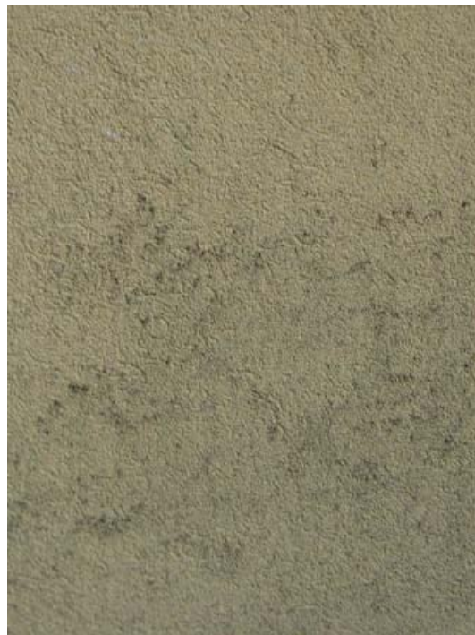
Obr. 11 Důsledek použití nevhodné omítky. Obr. 12 Výskyt plísní na ETICS.
