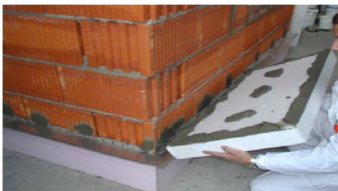
Obr. 4 Osadenie dosky tepelnej izolácie do ukončovacej lišty .
