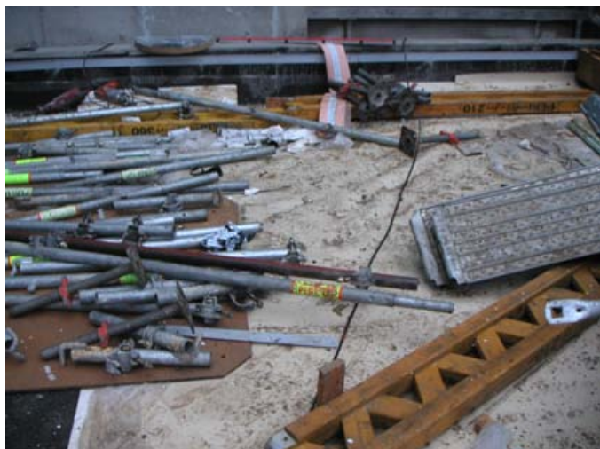
Skládka lešení na položené hydroizolaci zelené střechy atria
