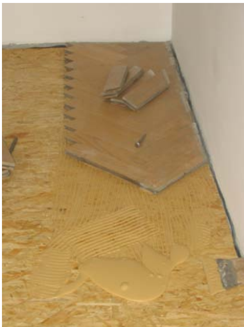
Obr. 4 Ukladanie vlysiek do tmelu
