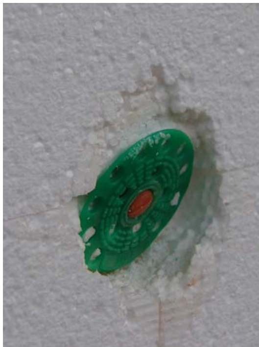
Obr. 4 Hmoždinka neosazená kolmo
