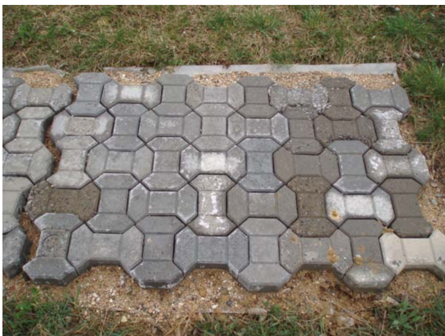
Experimentální úsek zámkové dlažby ve venkovním prostředí po 29 týdnech (15 zmrazovacích cyklů)
