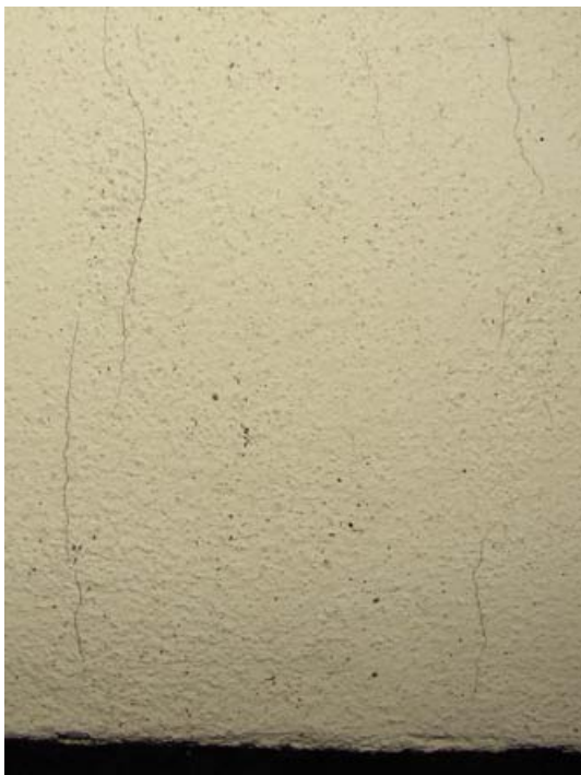
Obr. 11 Důsledek použití nevhodné omítky. Obr. 12 Výskyt plísní na ETICS.
