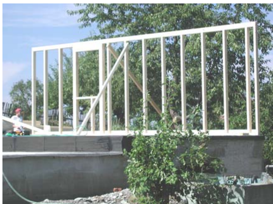
Dočasná fixace stěn vzpěrami
