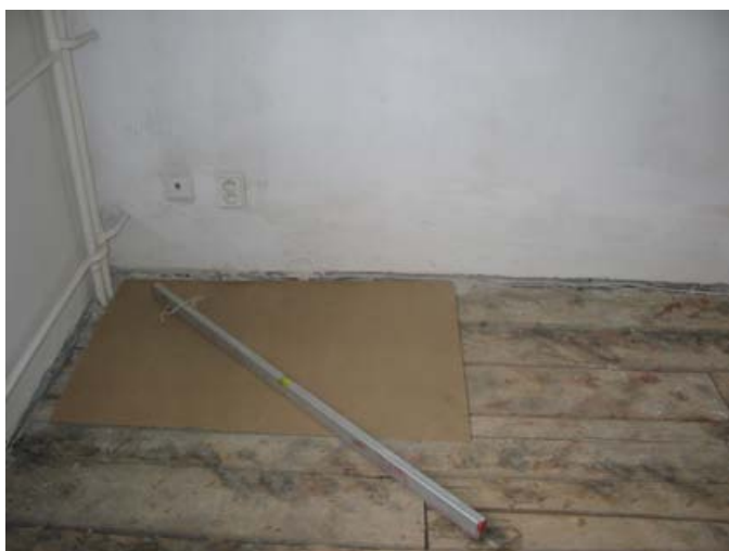
Obr. 2 Kontrola rovinnosti podkladnej vrstvy
