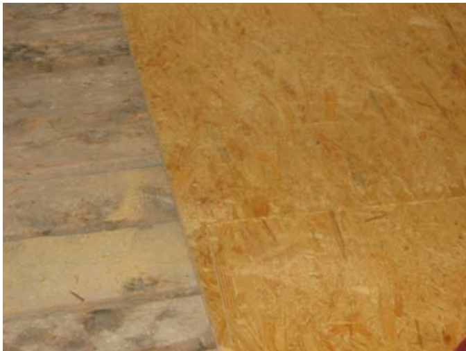
Obr. 3 Uloženie OSB dosiek
