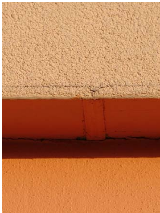
Obr. 10 Důsledek nekvalitního vyztužení u zkladací lišty.
