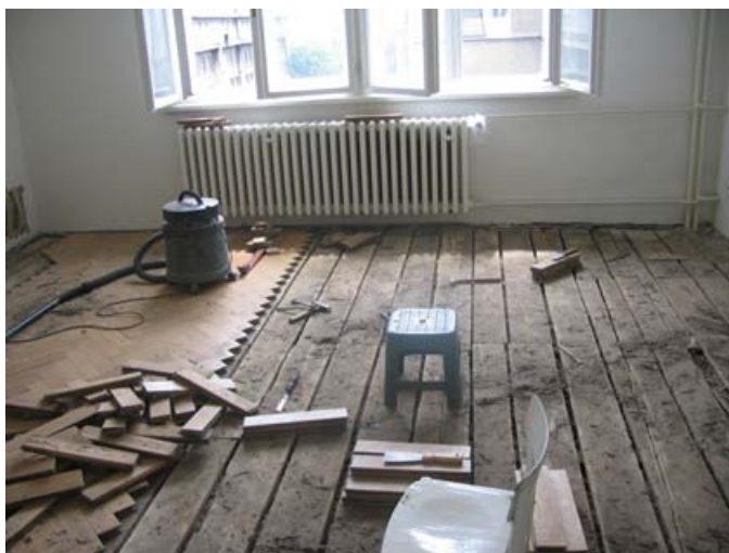
Obr. 1 Demontáž drevenej vlysovej podlahy
