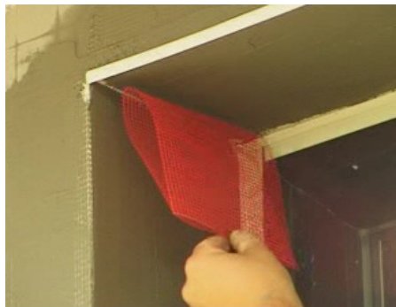
Obr. 7 Práce na zateplení detailov okenných otvorov
