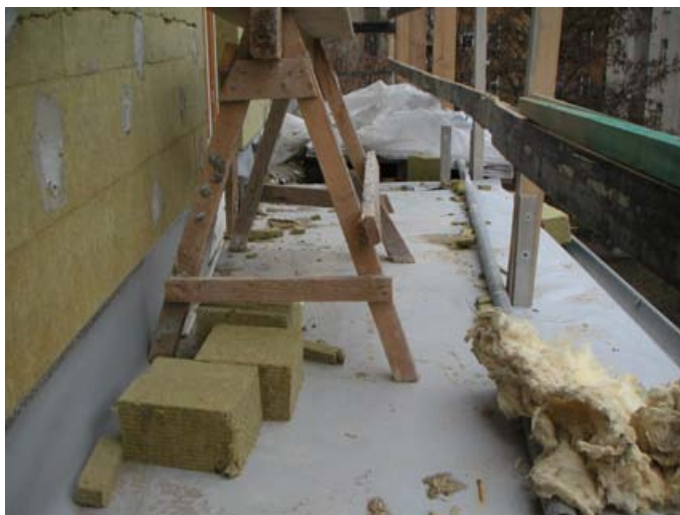
Provádění fasády po položení hydroizolace terasy.
