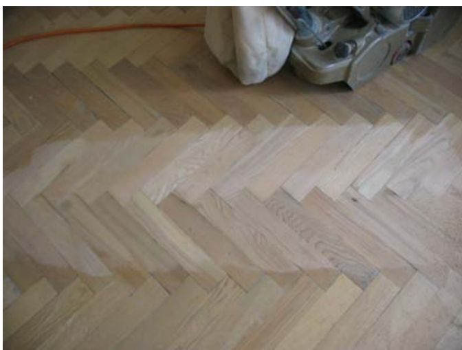
Obr. 5 Brúsenie uloženej vlozovej podlahy
