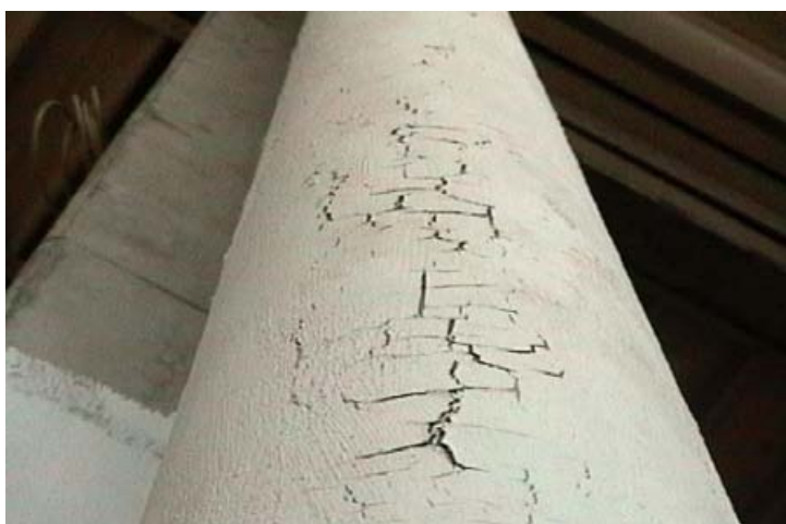
Obr.4. Rozpad zpěňujícího nátěru na ocelové rouře vlivem kondenzující vysoké vzdušné vlhkosti při aplikaci
