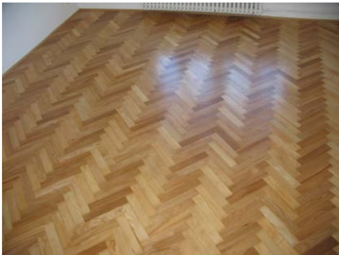
Obr. 6 Zrekonštruovaná podlaha s využitím starých vlysov
