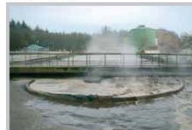
Čističky odpadních vod
